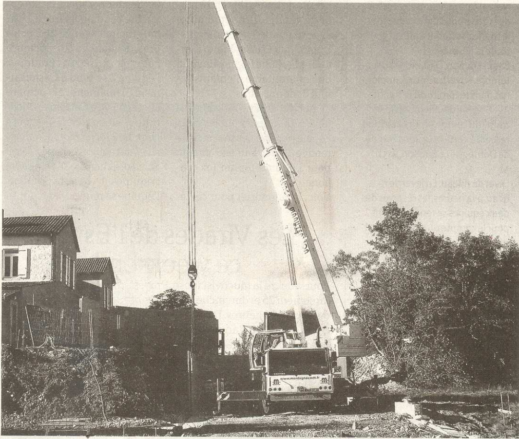
Les blocs aux dimensions et poids imposants ont été posés dans le ferrailage de la fondation.
